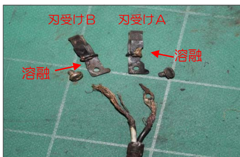
▲刃受けの状況。端子の一部が溶融している。
