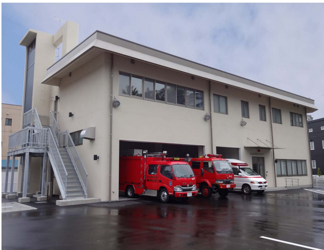
気仙沼消防署古町出張所(平成26年7月竣工)
